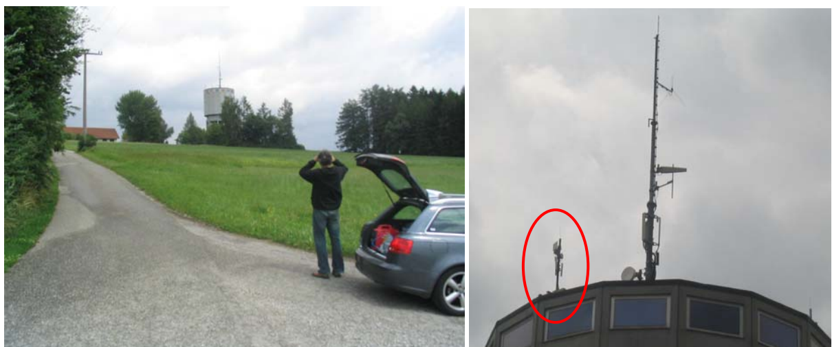
Bild 3.5 WiMAX-Standort "Wasserturm Wagmannsberg" von Messpunkt 1 aus gesehen (links); Detailansicht der Antennen (rechts)
